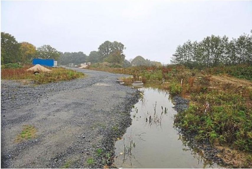
Der Schotter liegt schon fast zwei Jahre. Jetzt kann die da zugehörige Asphaltdecke kommen. Foto: Axel Roll
